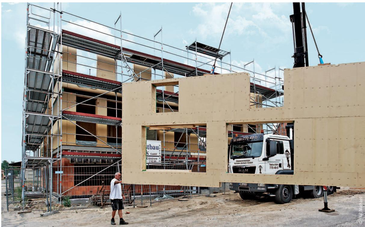
Vorgefertigte Außenwandelemente mit Holzfaserdämmung
