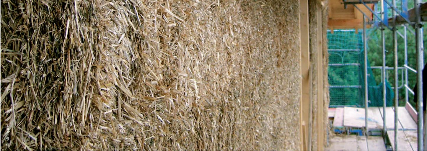
Strohballen zwischen einer Holzrahmenkonstruktion (außen)
