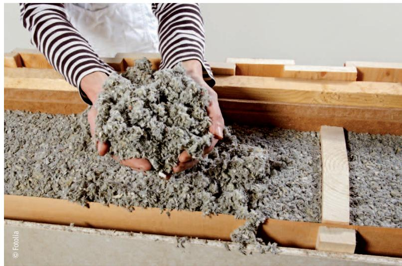
Zelluloseeinblasdämmung in einer Außenwand
