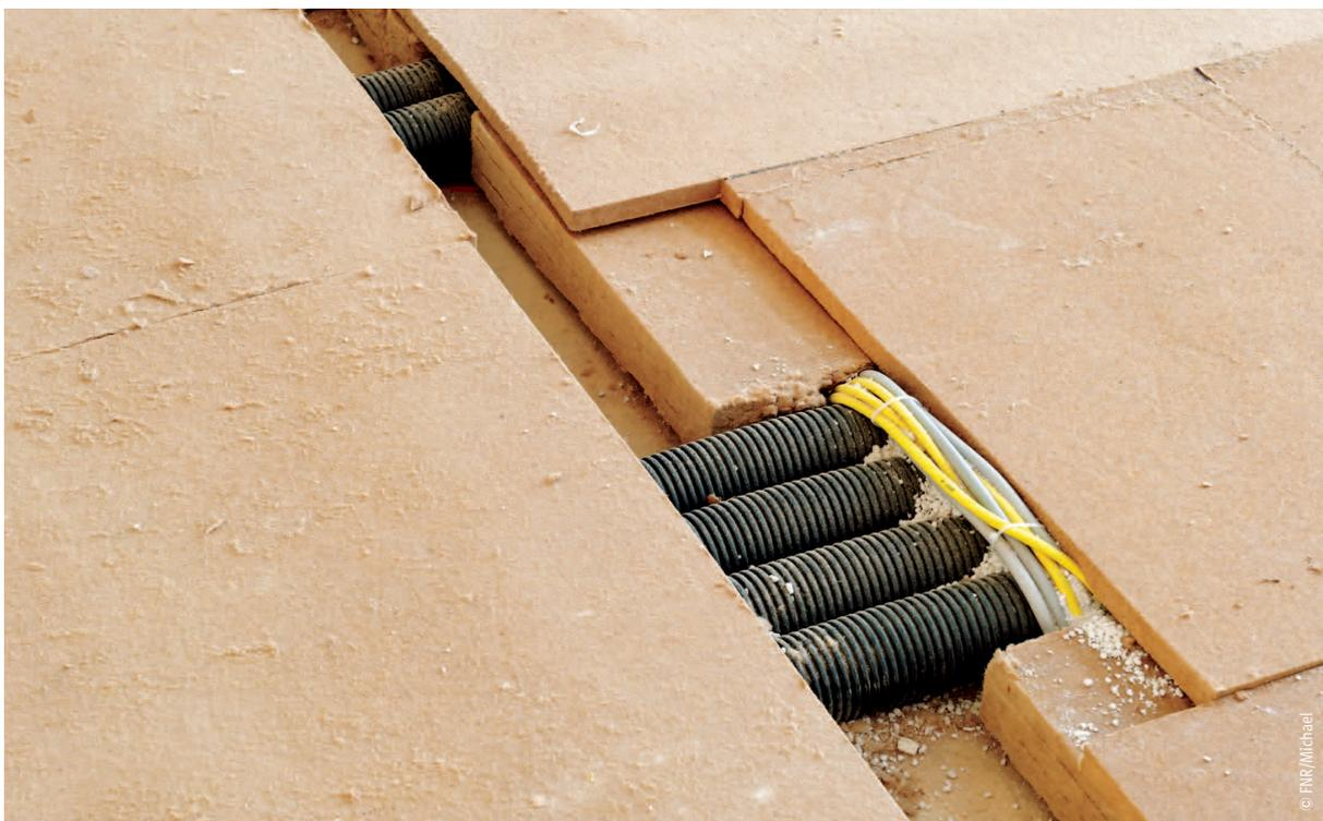
Holzfaserdämmstoffe im Deckenbereich
