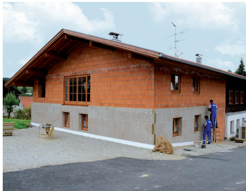
Außendämmung mit Holzwole-Dämmplatte
