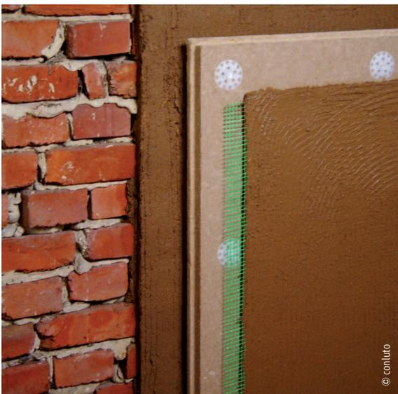
Innendämmung mit Holzfaserdämmplatten
