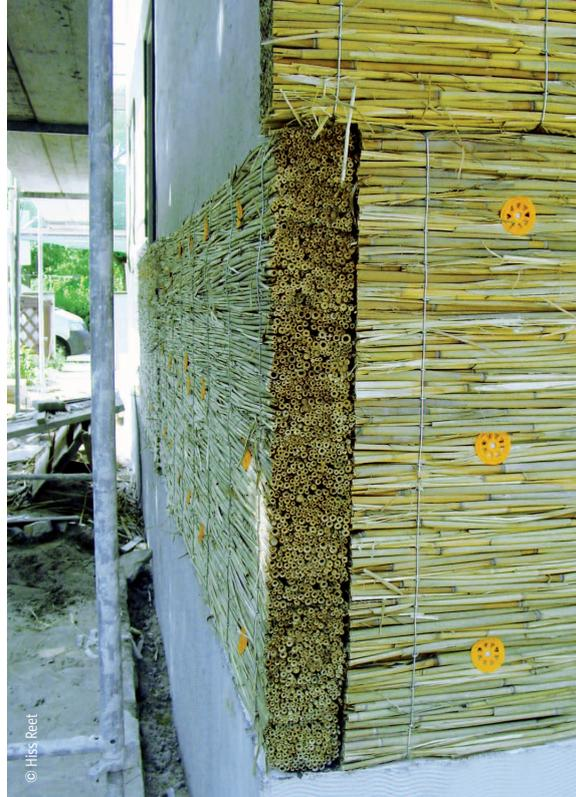
Mit Schilfplatten gedämmte Hausecke
