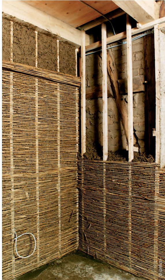
Konstruktion für eine Dämmschüttung
